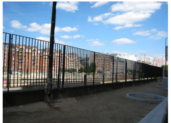
La nouvelle clôture qui sépare les emprises ferroviaires de l'espace public de la rue des longues raies, dans le 13 e (ZAC de Rungis)
