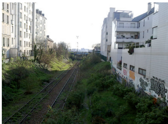
La portion de Petite Ceinture au niveau de la rue des Meuniers, dans le 12 e
