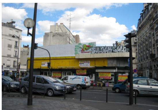
La gare de Saint-Ouen (18 e ) dans une photo ancienne et aujourd'hui
